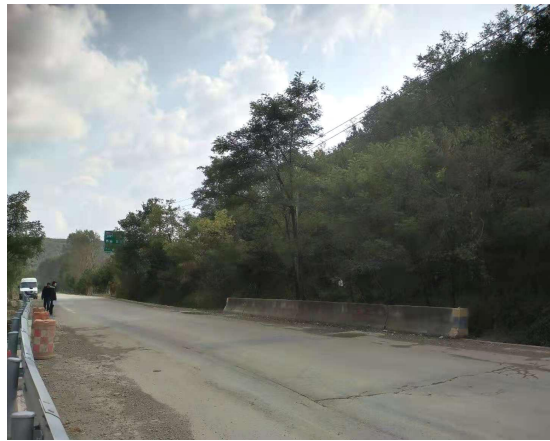
桥梁南侧（山坎）
