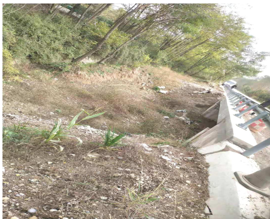
桥梁北侧（临高速公路侧）
